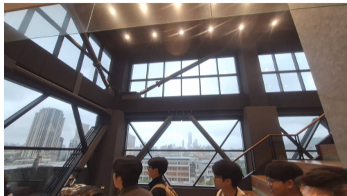
七樓減震與隔震設備：LRB 及鋼板阻尼器 (SPD)
