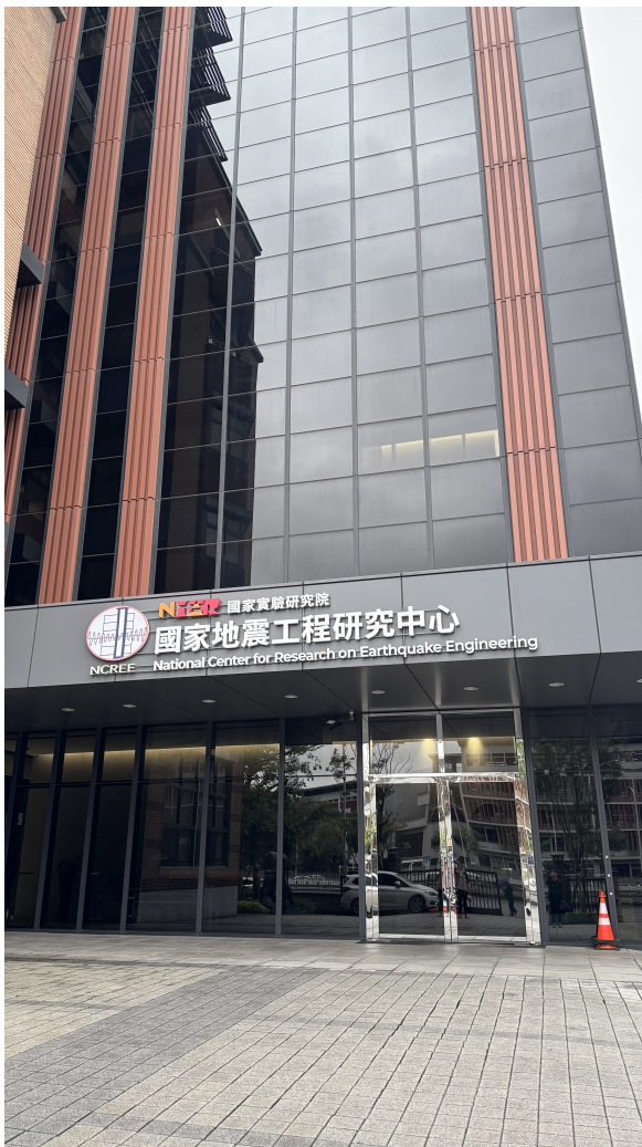
(a) 國家地震工程研究中心大樓外觀
