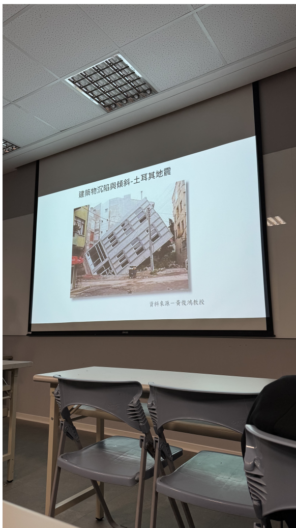
(a) 地震損壞建築案例展示
